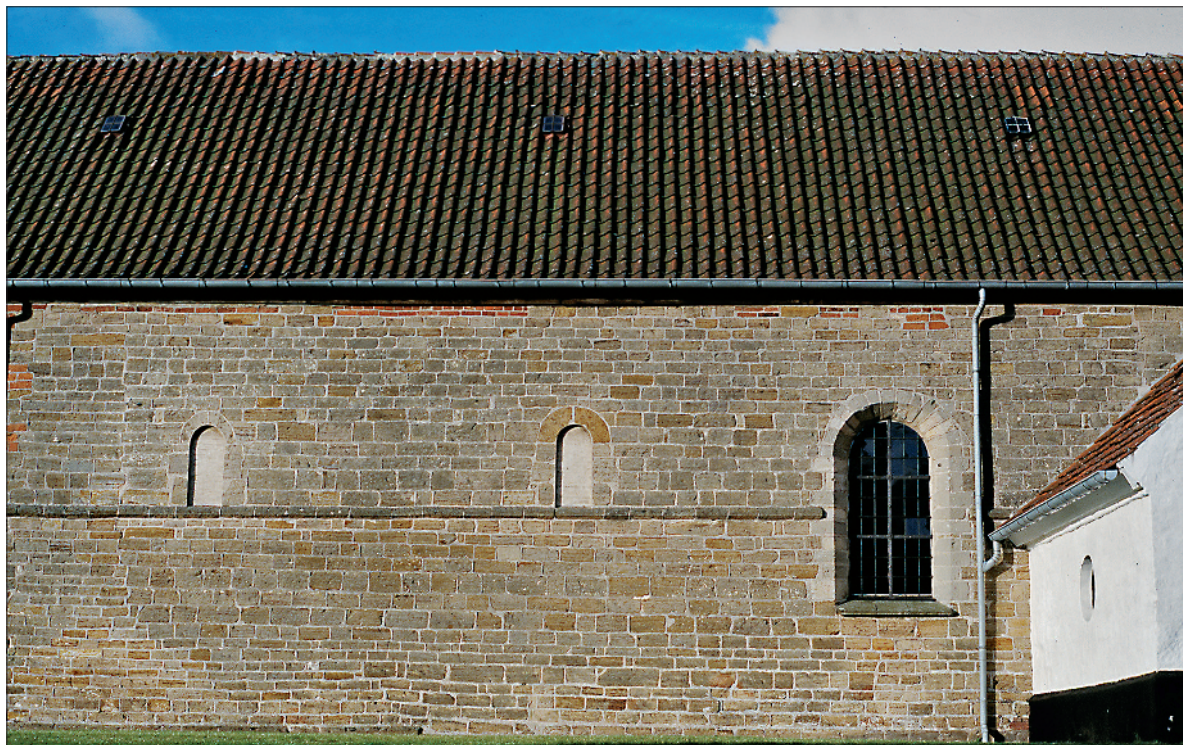
Fig. 4. Vejby Kirke, skibets nordmur med to enkeltsmigede vinduer og gennemløbende murbånd ved deres underkant. Bemærk her en dominans af ret grå sten (foto forfatteren).
